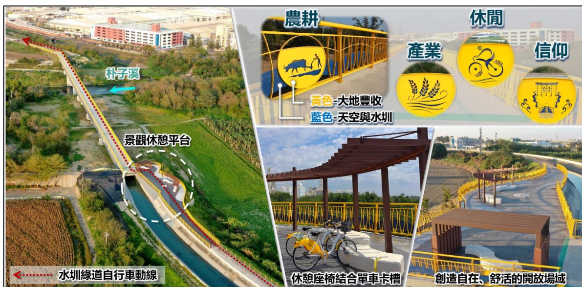
圖 14 朴子溪渡槽完成照
