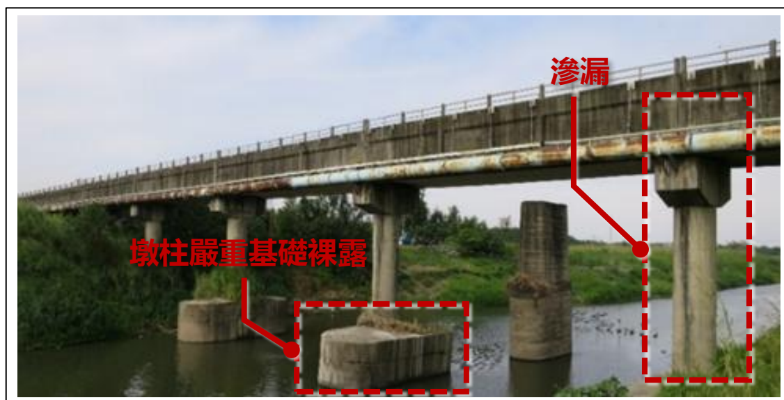
圖 1 朴子溪舊渡槽
